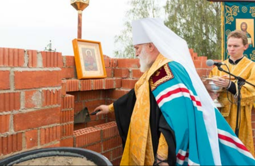
На фото: Закладка камня в осно- вание нового храма в честь Архистратига Михаила в деревне Новый Двор Минского района. 20 сентября 2014 г.
